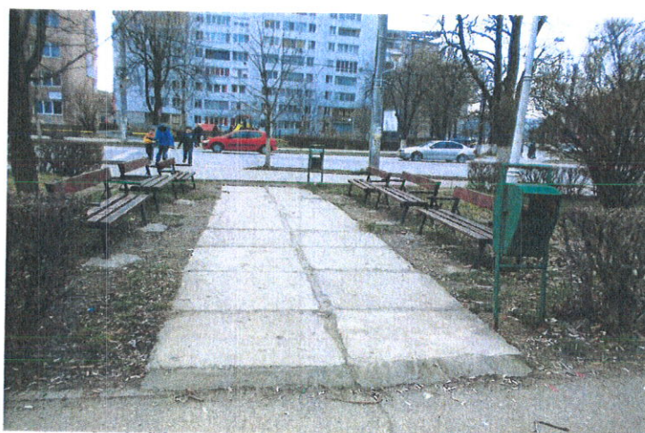
Foto 6. Trotuar din dale de beton și mobilier urban degradat
